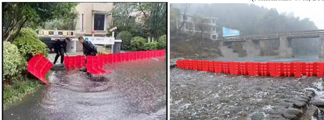
شکل ۱۵- نمونه‌ای از سازه‌های بافل L شکل برای کنترل و استهلاک انرژی جریان و قابل استفاده برای اهداف فرعی مانند: تنظیم ظرفیت جریان، کنترل سیلاب و آبگرفتگی در معابر شهری و نیازهای تعمیراتی و غیره در پایین‌دست می‌توان بهره برد.
