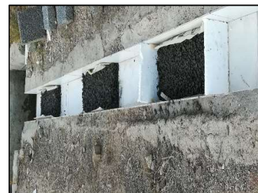
شکل ۱۳- بتن‌ریزی در کانال
